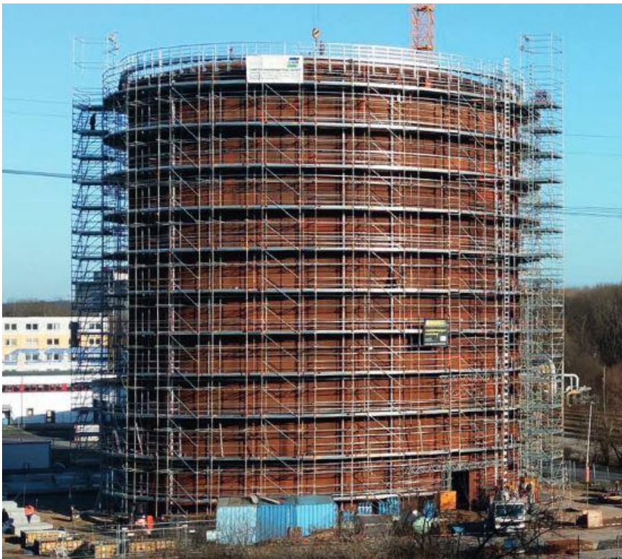
Neubrandenburger Wärmespeicher im Bau (Foto: Stadtwerke Neubrandenburg)
